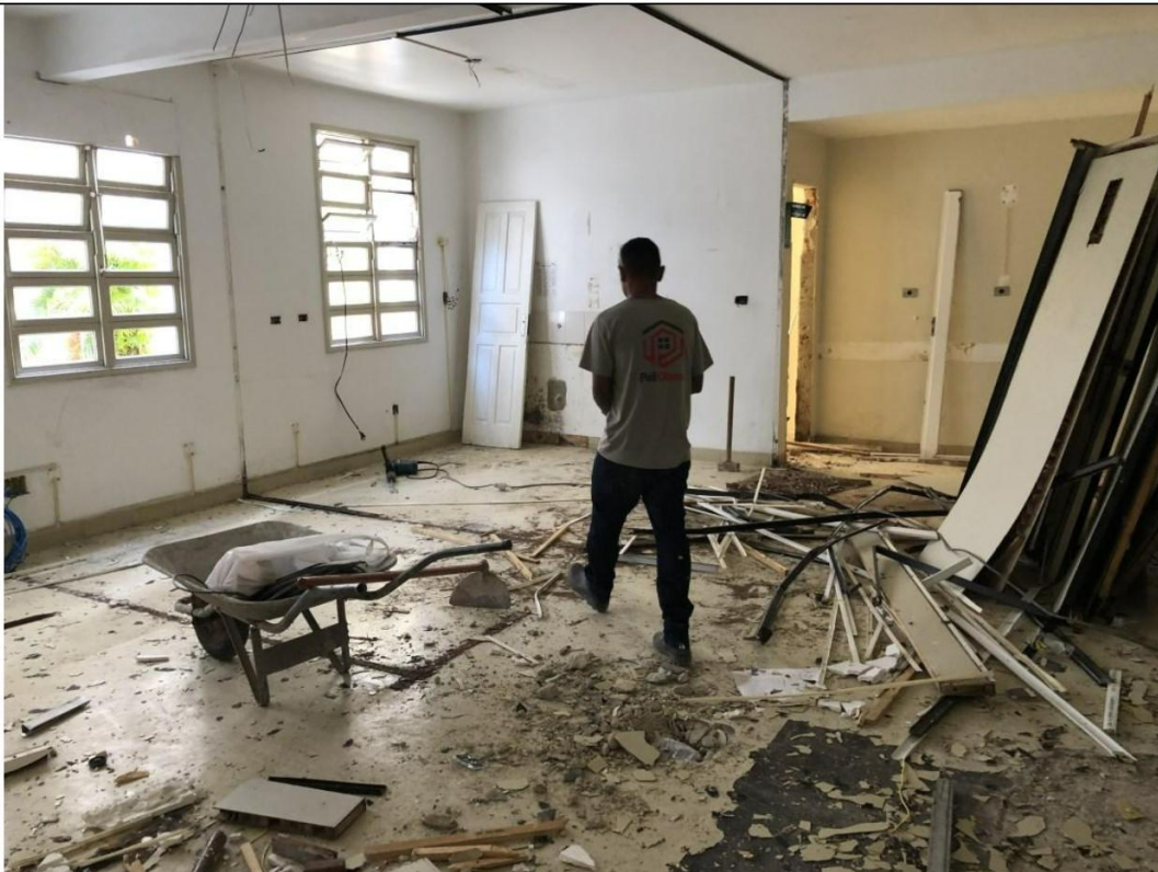
Legenda: Sala de coleta em desmontagem
