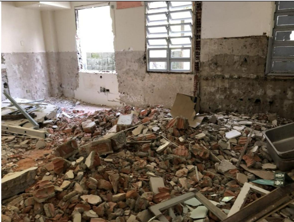
Legenda: Demolição de piso e paredes
