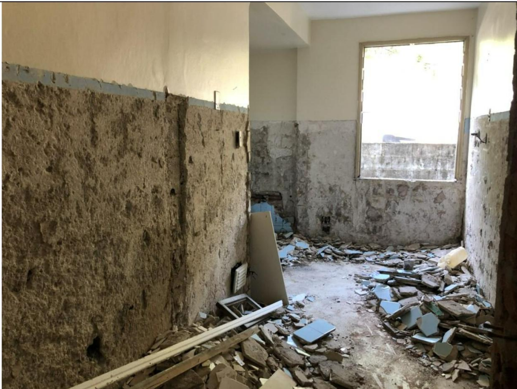
Legenda: Antiga sala de Autoclave em demolição
